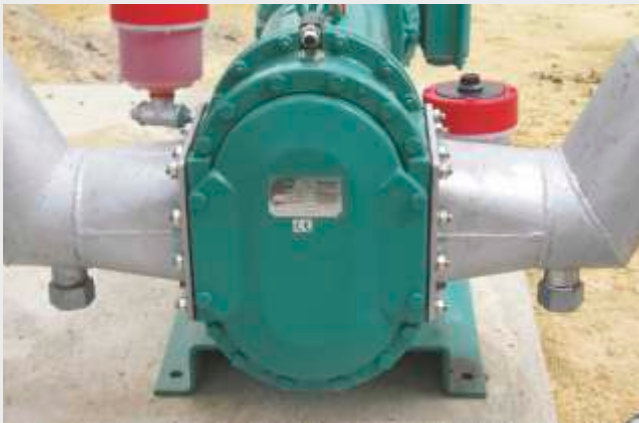
Bomba de alimentación para sustrato de biogás. Caudal hasta 40 m 3 /h bajo presión de 2 bar.
