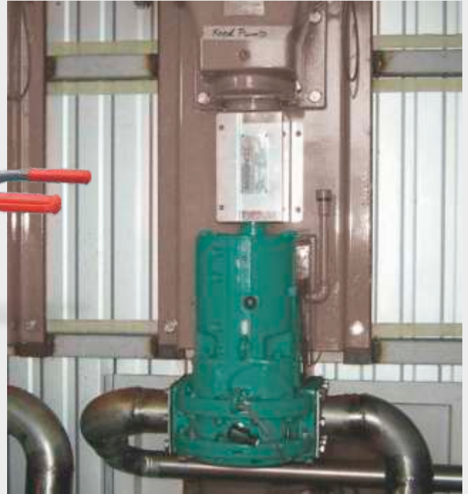
Una Bomba TORNADO® vertical en un container para alimentación de centrífuga con lodo de perforación de petróleo.
