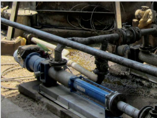
Una instalación de alimentación de centrífuga usando una bomba NEMO®BY
