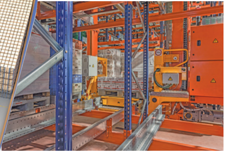
Imagen de un almacén automático con Pallet Shuttle compuesto por cinco niveles de carga y servido por un traselevador.
